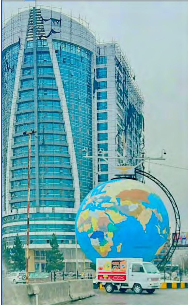
La Azim Tower, un recente centro commerciale nel centro di Kabul. (foto Jalalluddin Hakshanas, 2023, da Google)
